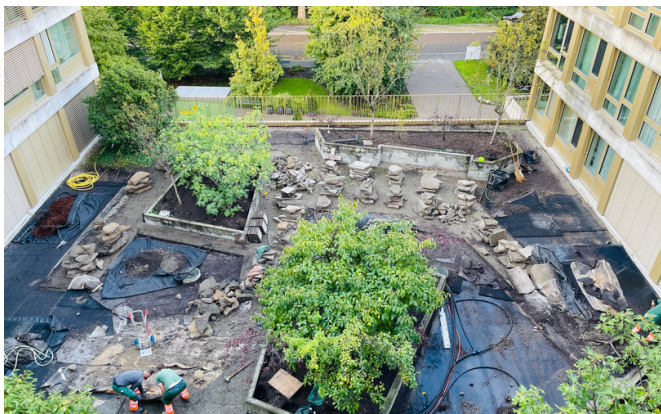
21.09.2022 Die Arbeiten beginnen.
