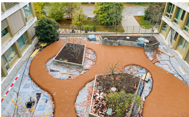
31.10.2022 Der neue Boden nimmt Form an.
